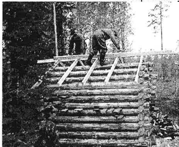
Kuva 2. Timpurit saunan liiterin teossa.
